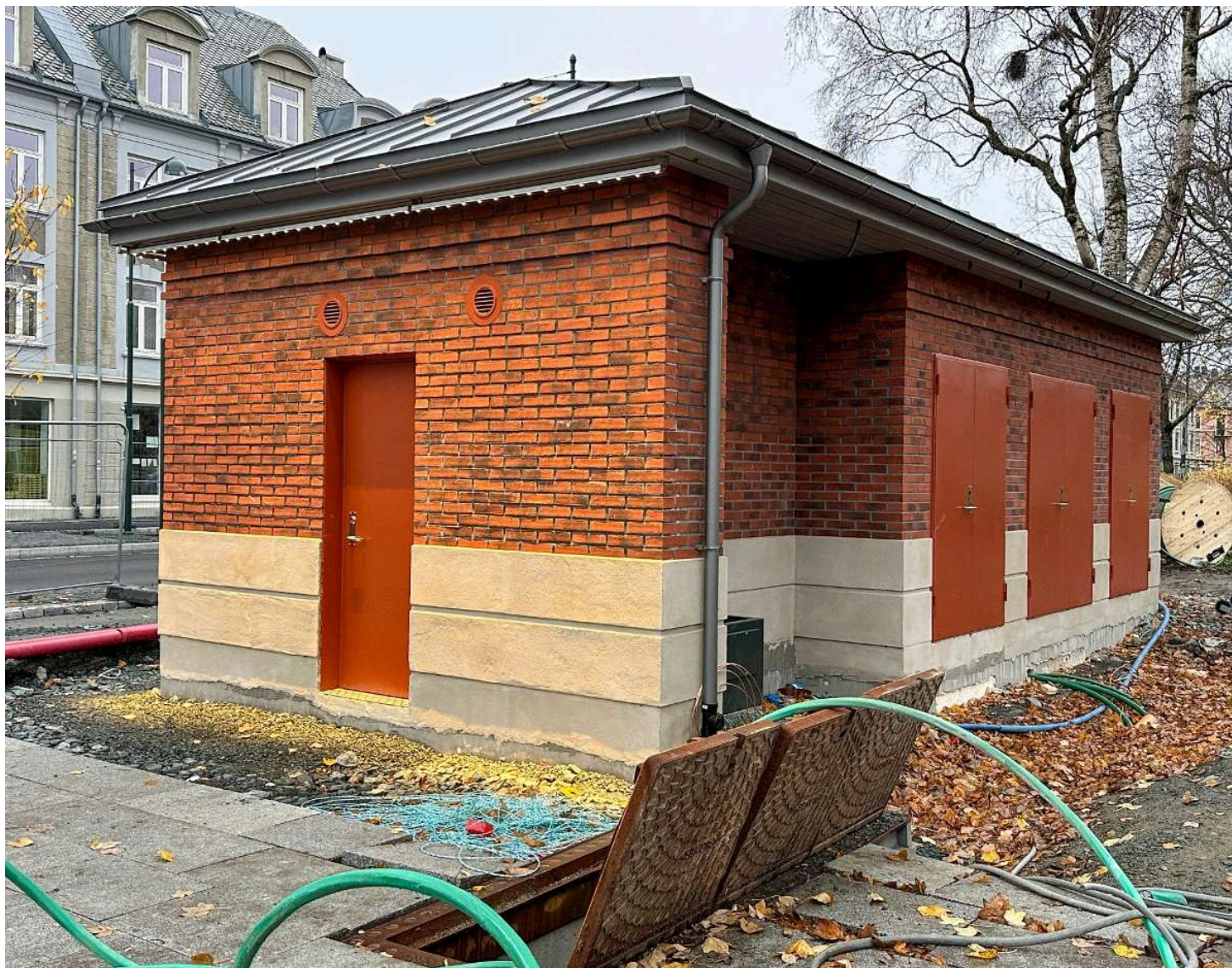
Slik ser toalett/trafobygget ut fra baksiden. Det står fortsatt gjerdet av ved Innherredsveien. Foto: Roman Prokopenko
