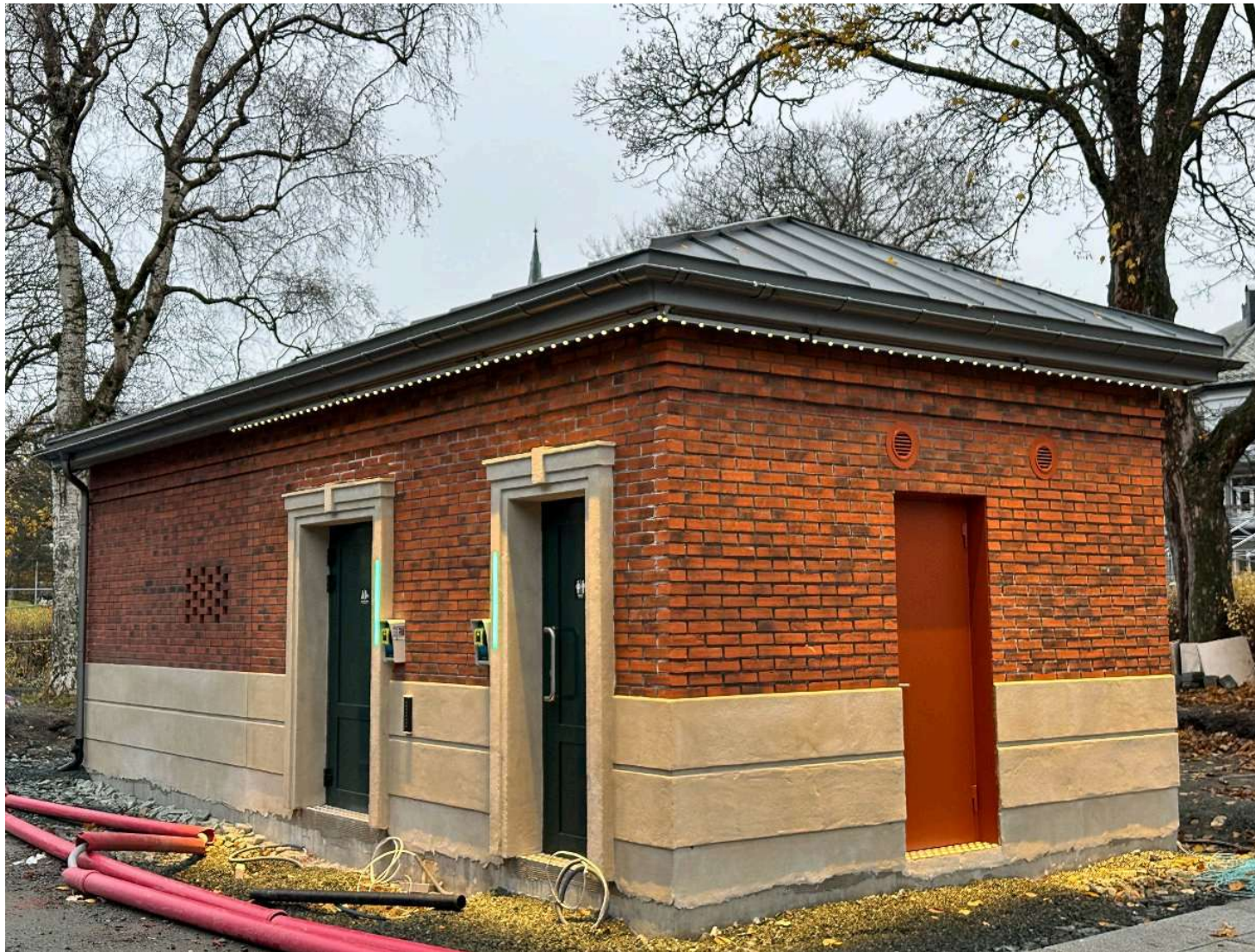
Denne lille bygningen i Lademoparken er nominert til Arkitekturopprørets hederspris i år. Foto: Roman Prokopenko
